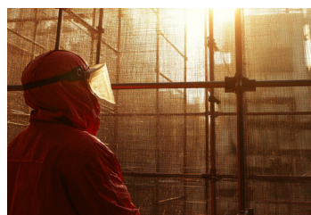
Échafaudages et nettoyage en hauteur
